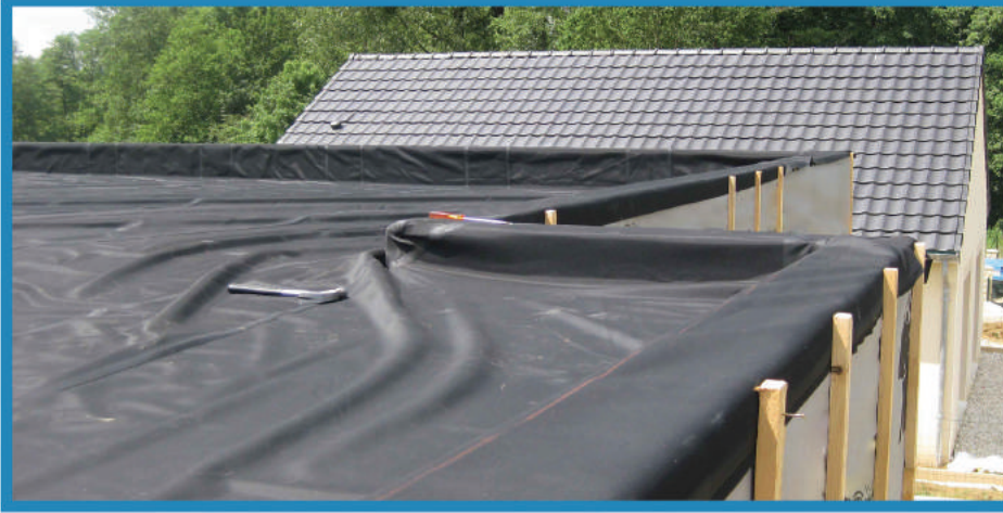
Geotekstil Keçeli EPDM Membran Uygulaması
